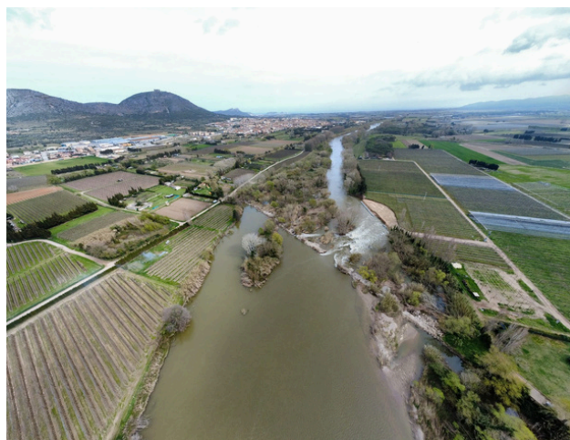
Vista aèria del riu Ter a l'alçada de la resclosa d'Ullà.
