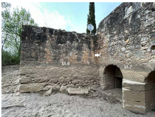
Fig. 16: Detall del mur M-8. Es pot observar com es lliura contra el mur M-7 del cadiral.
