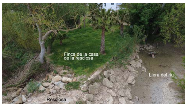
Fig. 5: Vista de l'estrep sud-oest de la resclosa. Es pot apreciar com la finca de la casa de la resclosa s'hi posa per damunt.
