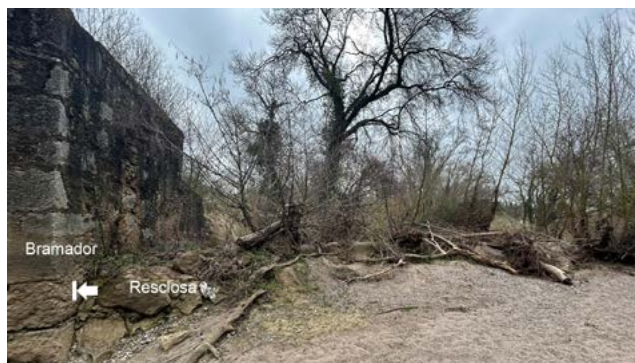
Fig. 6: Detall de l'estrep nord-est de la resclosa. Es pot observar com es lliura contra la paret del bramador.
