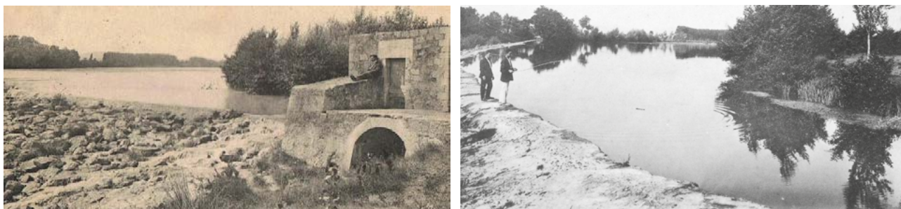
Fig. 12: A la fotografia de l'esquerra, d'inici del segle XX, el lliscat de la coronació i del talús interior encara no s'havia aplicat. A la fotografia de la dreta, de la primera meitat avançada del segle XX, els personatges que estan pescant ho fan ja sobre del lliscat de morter. Fons Fotogràfic Municipal. Museu de la Mediterrània de Torroella de Montgrí.
