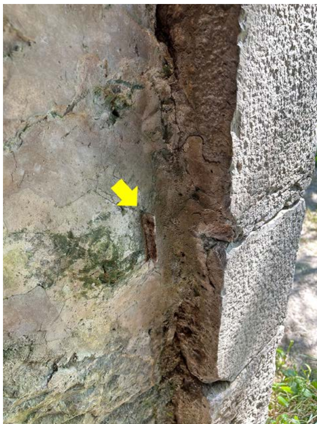
Fig. 44: Detall de la làmina de ferro que fixava el pany de la porta.
