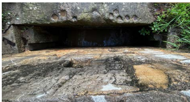
Fig. 37: Vista zenital de l'obertura OB-17 per la qual es desplaçava verticalment la comporta del bramador.
