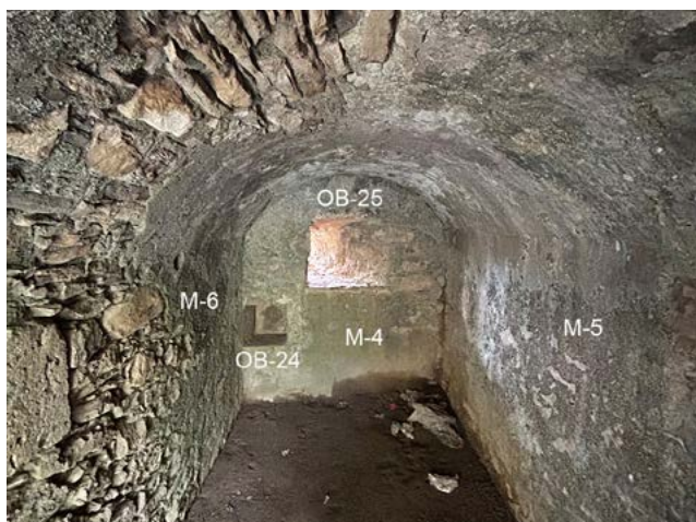
Fig. 46: Interior de l'estança del bramador.
