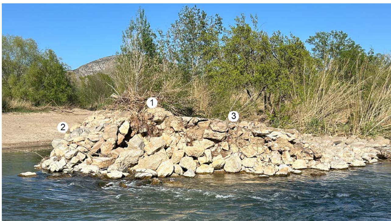
Fig. 10: Vista del tall format per l'esquerra on s'observen les parts de la resclosa. (1) Coronació, (2) talús exterior, (3) talús interior.
