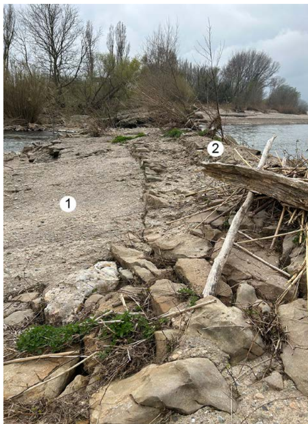
Fig. 9: (1) Detall del lliscat que recobreix el talús interior, (2) mur de la coronació.
