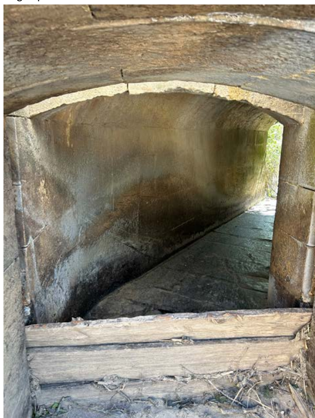
Fig. 34: Interior del canal del bramador, es pot veure l'angle que forma el seu traçat.
