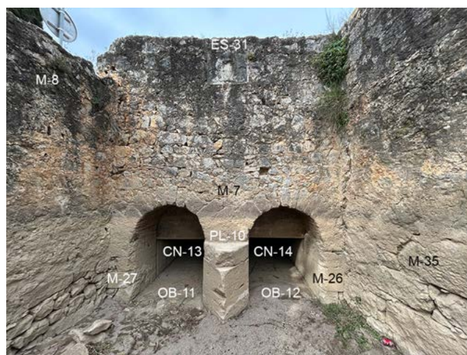
Fig. 19: Vista frontal de la façana sud-oest del cadiral.
