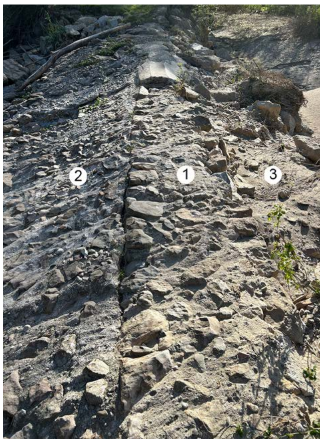
Fig. 8: (1) Detall del mur que forma la coronació de la resclosa, (2) talús interior, (3) talús exterior.
