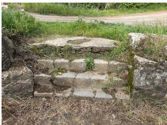
Fig. 40: Escala ESC-22 que permet l'accés al pati des del camí de la mota.
