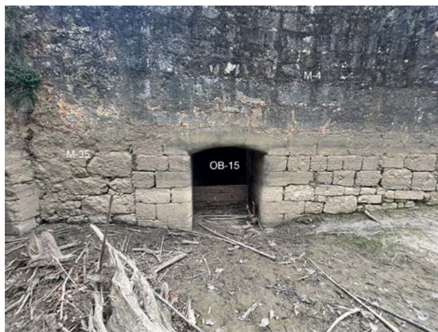
Fig. 33: Porta del pis inferior del bramador que permet el pas de l'aigua pel canal CN-16.
