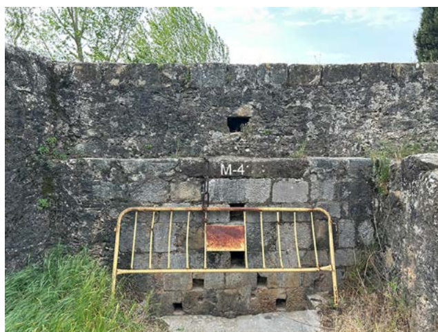
Fig. 41: Vista frontal de la cara interior del mur M-4 al pis superior del bramador i de l'obertura OB-17 de la comporta.
