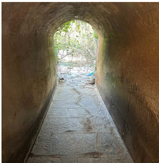
Fig. 35: Detall de les lloses de calcària que pavimenten l'interior del canal CN-16 del bramador.
