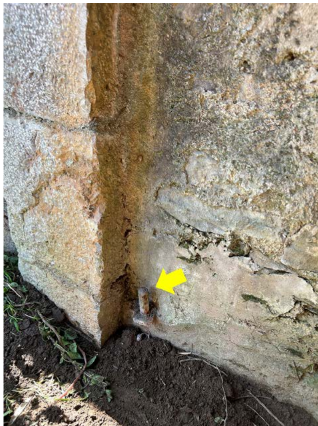
Fig. 43: Detall del piu del batent de fusta de la porta situat en el brancal del costat esquerre.
