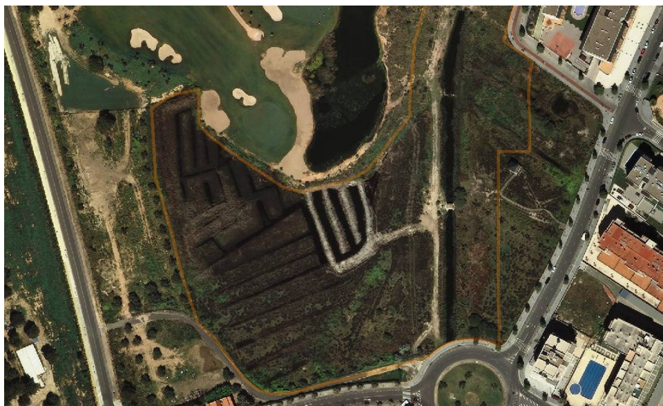
Figura 1 – Ortoimatge del sector meridional de l'EIN de la Sèquia Major de Vila-seca amb els límits indicats amb traç de color taronja i on s'observa clarament, a la part central de la imatge, les actuacions realitzades com a prova pilot per a la millora de l'hàbitat del fartet. Font: ICC
