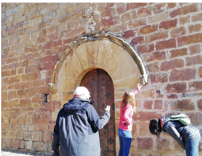
Inspecció de l'estat d'elements constructius de la portalada de Sant Romà de Llabià. (Febrer 2022)
