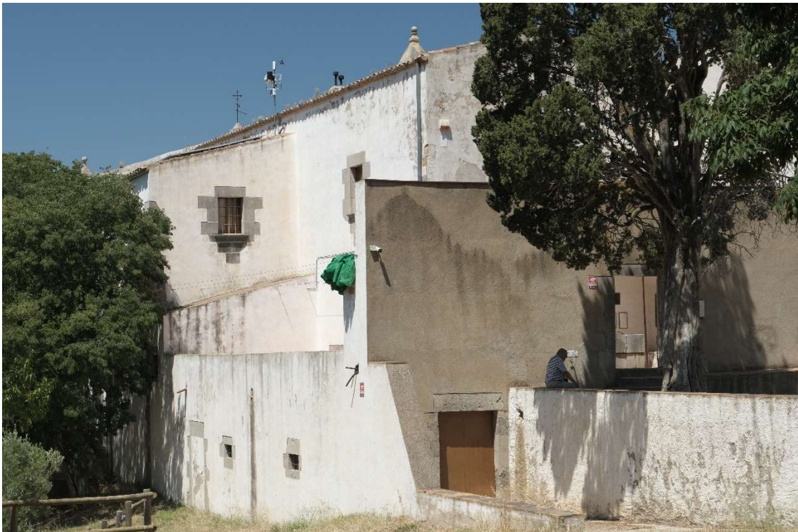
Figura 14. Vista general de les façanes sud i oest de l'ermita de Santa Caterina.
