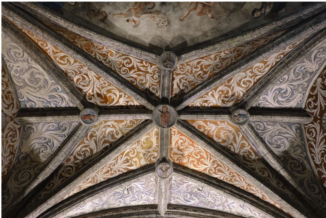
Figura 27. Volta de creueria amb cadenes i terçolets a la part del creuer de la capella.
