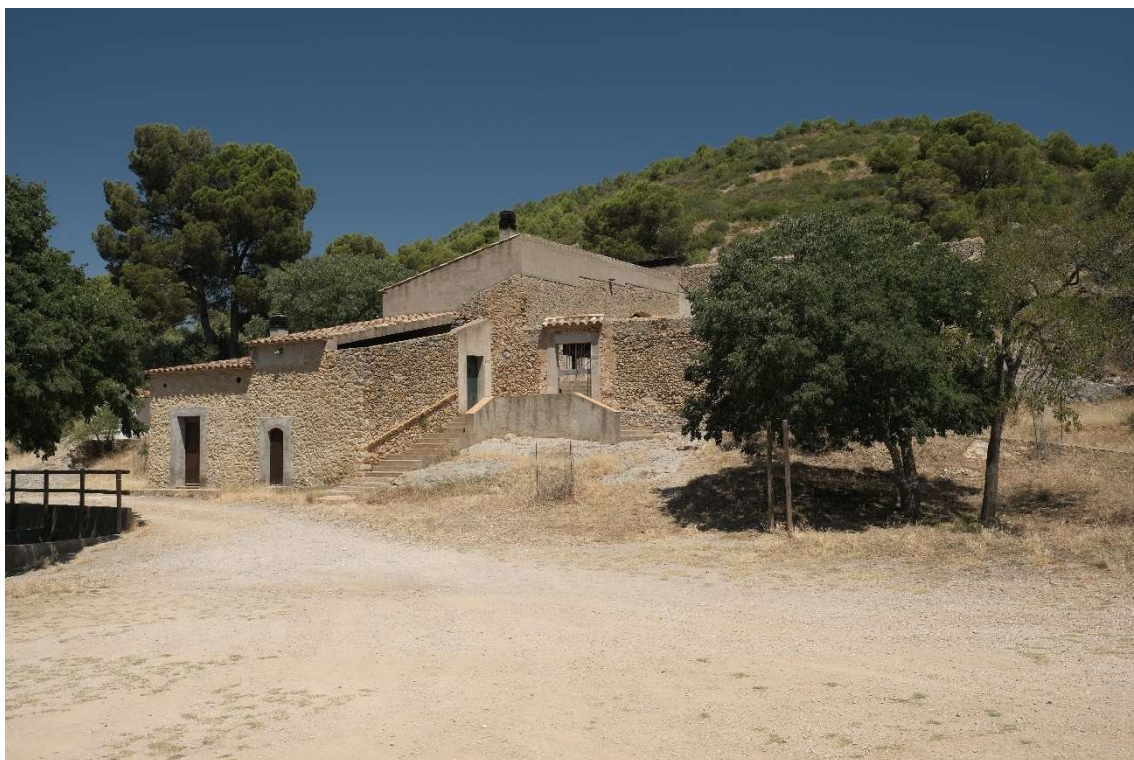
Figura 16. Vista general del cortal de Santa Caterina.
