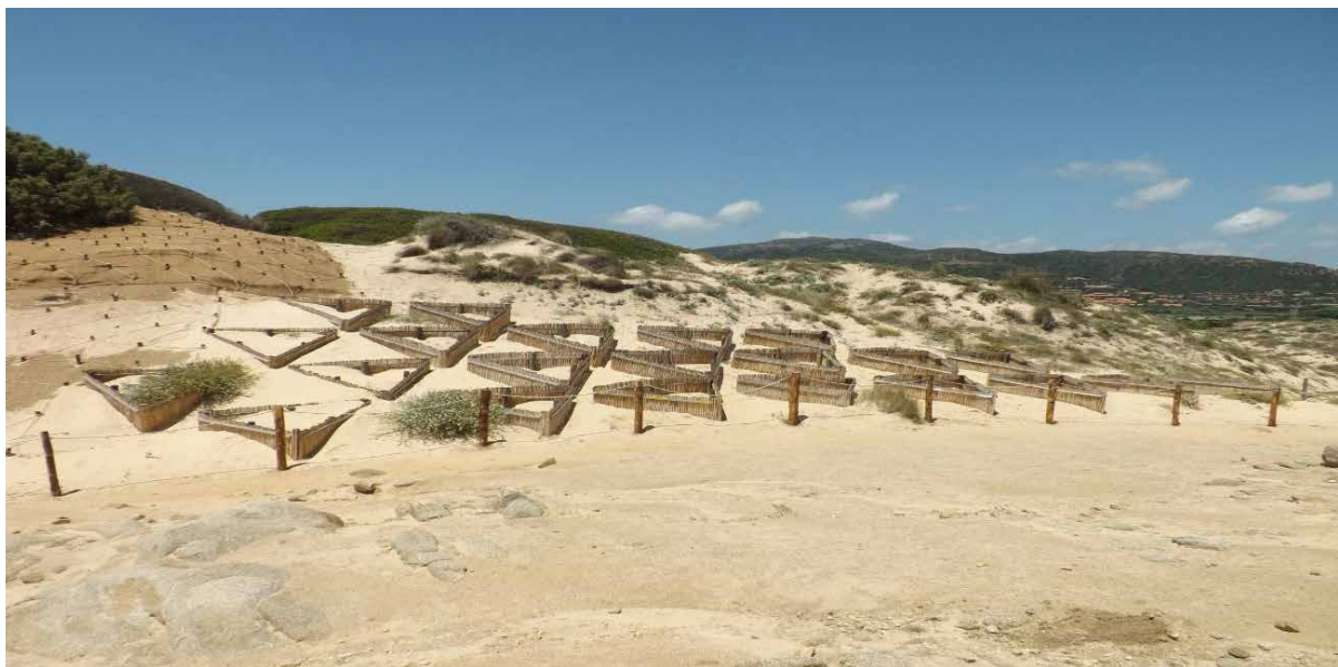
Figura 10. Eficacia de las redes de fibra vegetal de coco y de las empalizadas.
