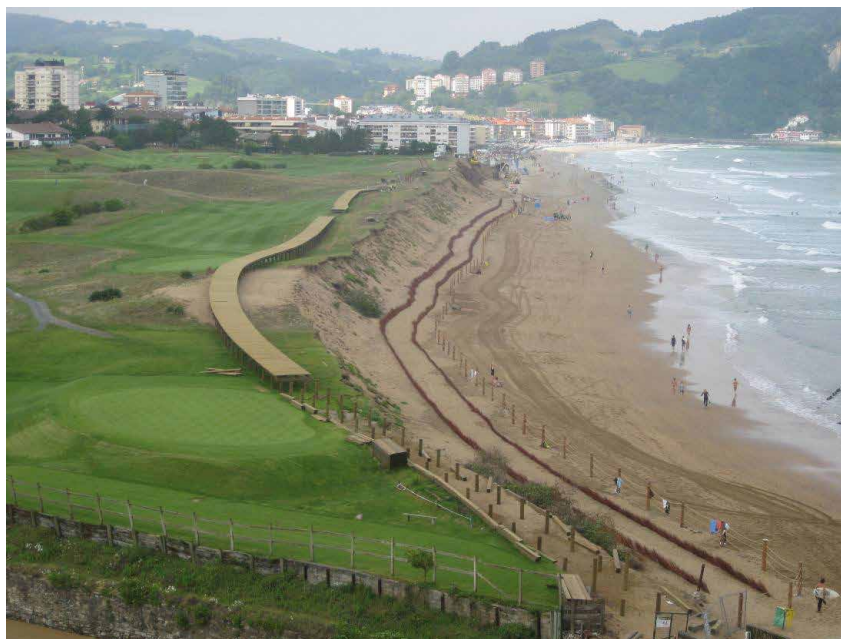
Figura 16. Estado de las dunas de Zarautz una vez restaurados los desperfectos del temporal de 2014. En la zona supramareal ya se han instalado captadores y se colocaban pasarelas de madera tratada.
