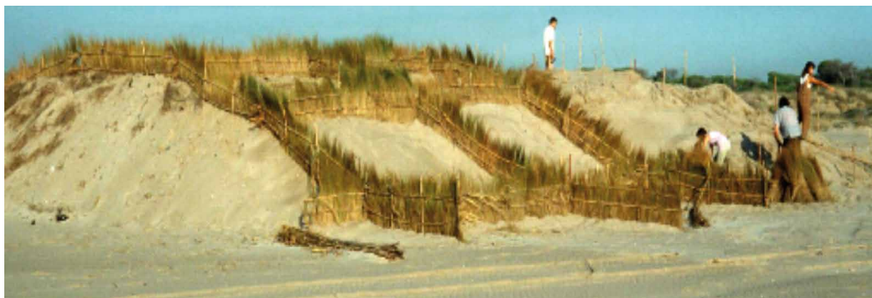
Foto 12. Fijación de la arena mediante empalizadas de caña ( Arundo donax ) y borró ( Spartina versicolor ). El borró es una planta que crece en la parte más externa de las malladas y que tradicionalmente se ha utilizado para los tejados de las barracas.
