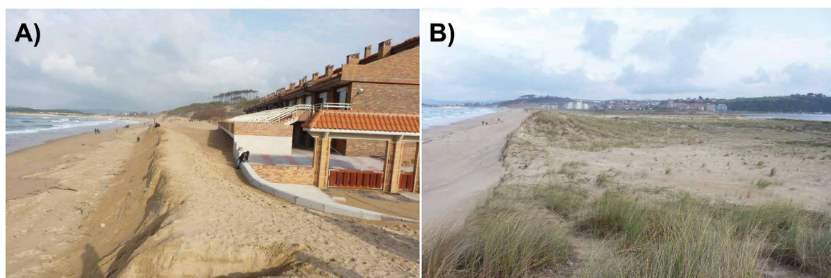
Figura 12. A) Restos de la barra artificial arenosa construida como parapeto de la urbanización en las dunas de Somo, cuyo frente fue erosionado, dejando un escarpe subvertical, y se redujo su anchura. B) Escarpes erosivos generalizados y mantos arenosos de desbordamiento sobre la duna culminante de la flecha arenosa de El Puntal de Somo.
