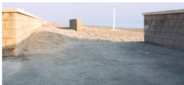
Foto 7. Detalle del paseo marítimo que se extendía con una longitud de 5,5 km al sur del paseo marítimo elevado y a lo largo de toda la playa de la Devesa. Estaba constituido por un murete de 1,20 m de altura, adosado en su parte interna a una carretera de unos 5 m de ancho y con accesos a la playa cada determinados metros.
