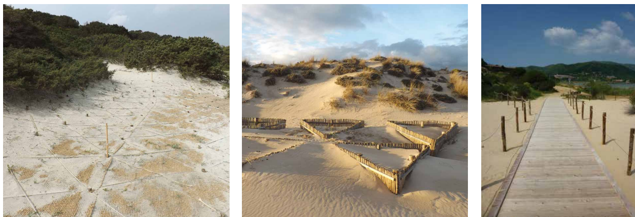
Figura 5. a. Redes de fibra vegetal de coco. b. Empalizadas de caña. c. Pasarelas de madera.
