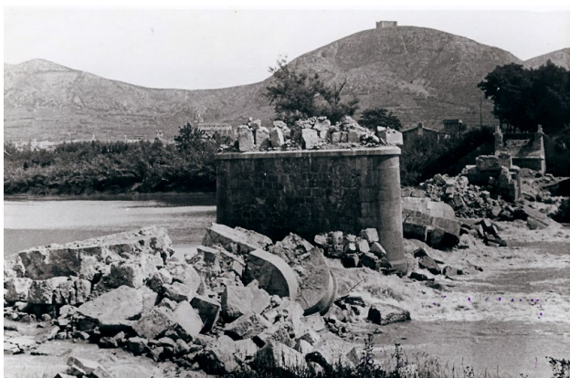
Figura 24. El Pont vell de Torroella enrunat
