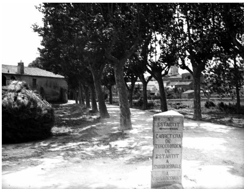
9 Fargas, C. (1920). Encreuament de Verges a Torroella. Al fons el mas Pi de Verges. Arxiu fotogràfic Centre Excursionista de Catalunya.
